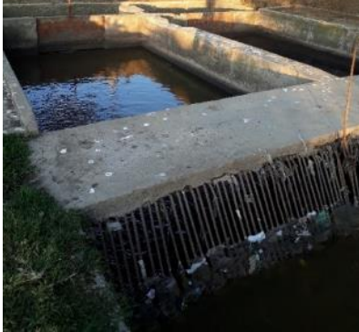
Image H1. Une installation fermée de traitement des eaux usées.
